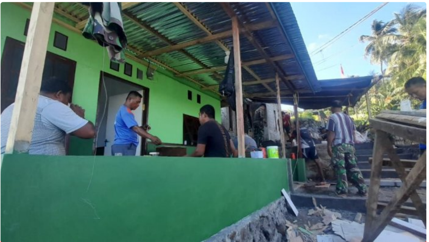
Pembangunan RTLH Keluarga Galvin Karaki pada TMMMD Ke-116 Kodim 1310 Bitung
