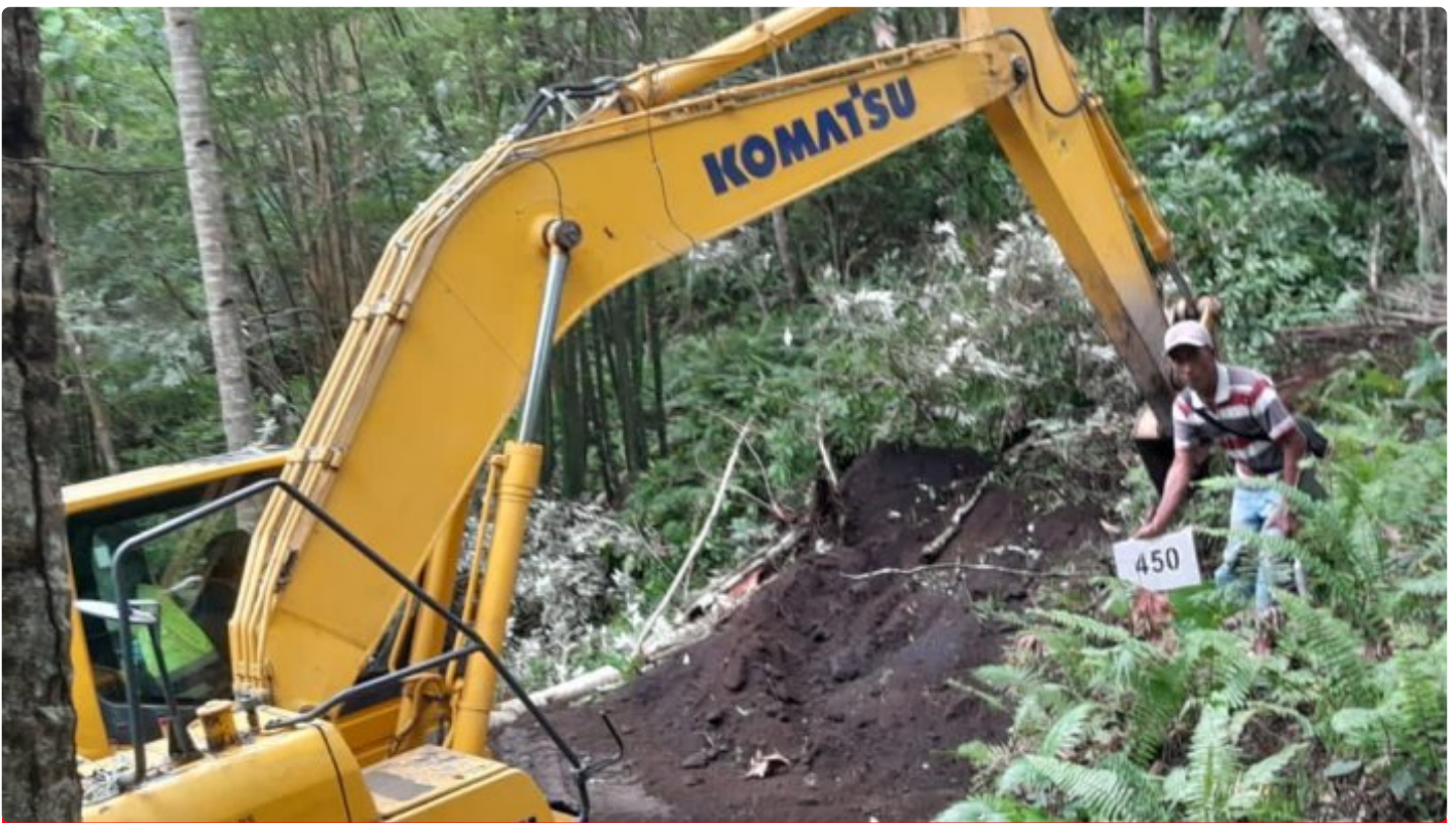
TMMMD Ke-116, Kebut Kerja pembuksan akses Jalan
