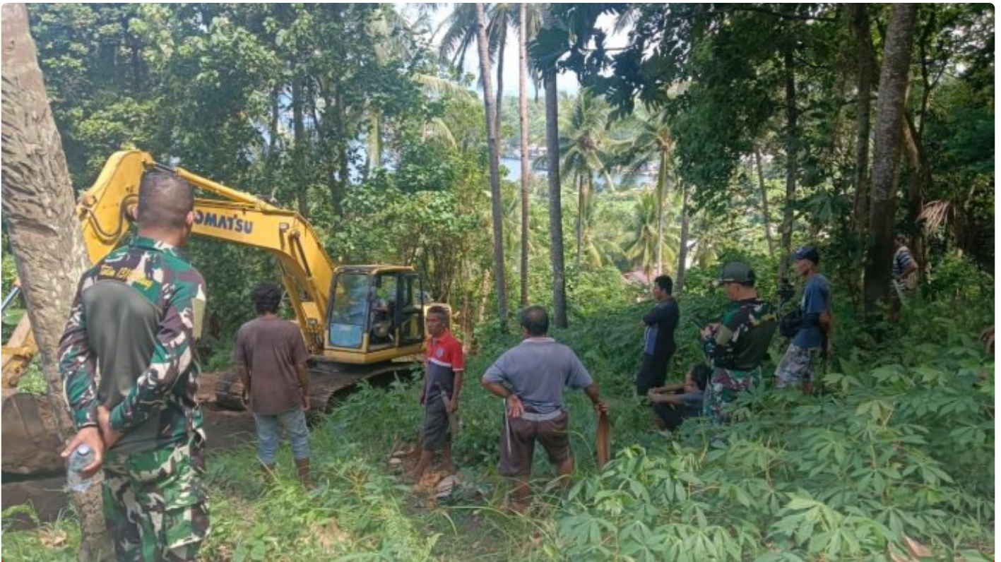
Dan Satgas TMMMD, Dandim Tinjau Pekerjaan Perntisan Jalan Pertanian
