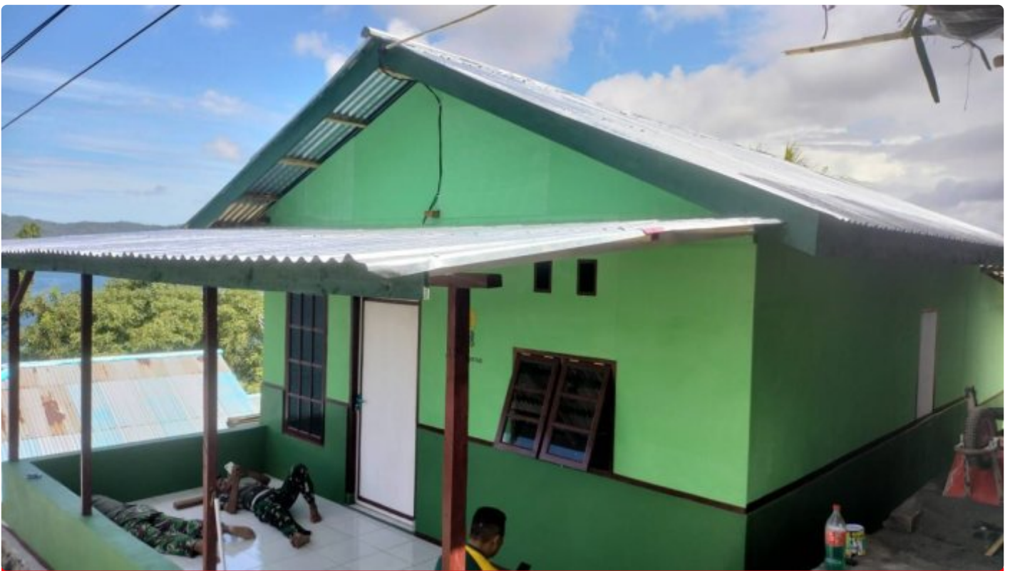
Renovasi RTLH TMMMD Ke-116 Kodim 1310 Bitung
